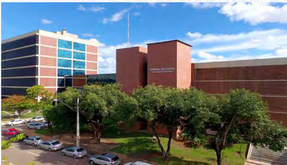
Figura 1 - Prédio sede do TCE/TO e Edifício Rui Barbosa
