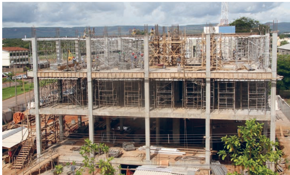
Obras do prédio anexo, iniciadas em julho de 2010
