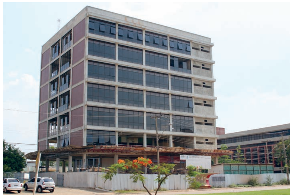
Estágio da obra em novembro de 2012
