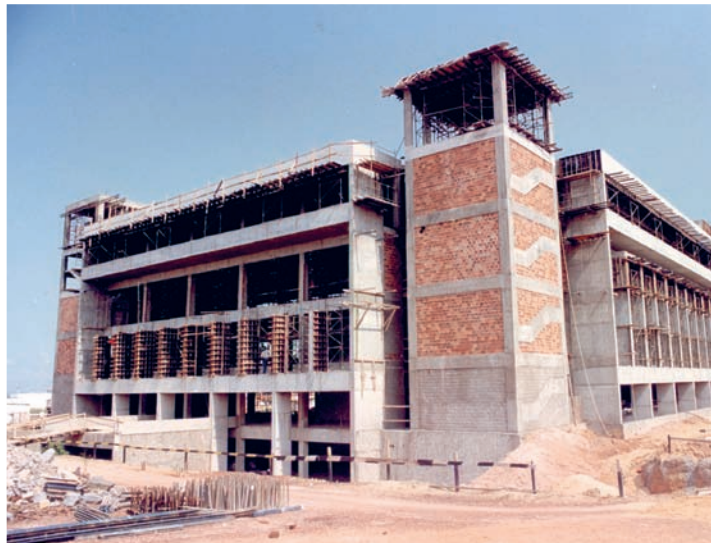
Obras, iniciadas em junho de 1996
