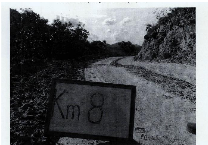
FOTO 40: Terraplenagem em execução (corte)
