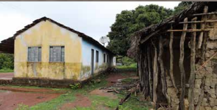
Antes e depois da Escola Polo Matas – Sabino dos Santos Rosa, localizada na comunidade quilombola Kalunga do Mimoso
